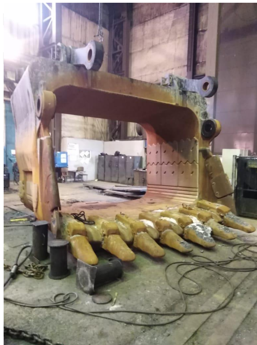
Фото 3 – Техническое обслуживание корпуса ковша в условиях ремонтного цеха
