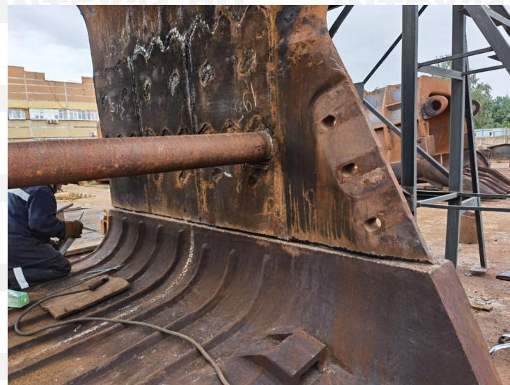
Фото 5 – Замена передней стенки корпуса ковша экскаватора WK-35
